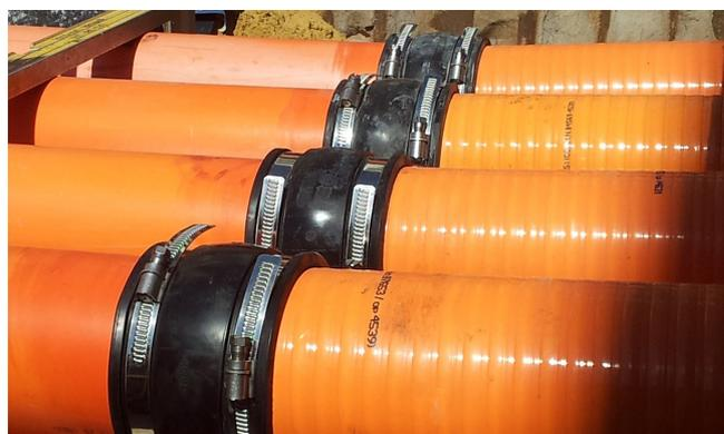
将弹性管路连接到刚性管路。
