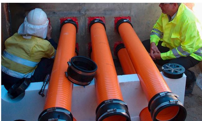
将Hateflex弹性管路安装到墙面插入件。
